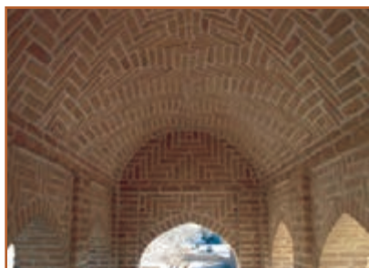
ب- استفاده از آجر برای سقف قوسی
