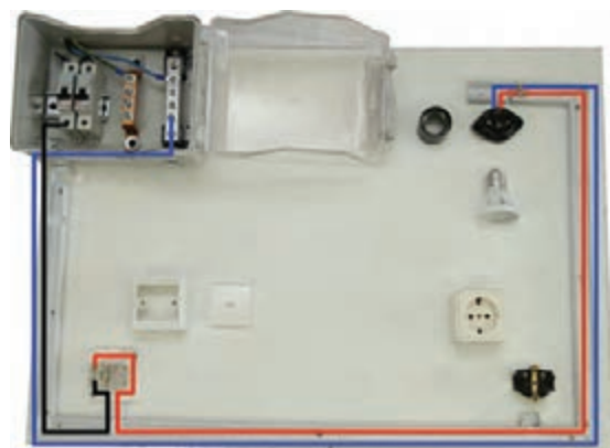
شکل ۸-۶ - انجام سیم کشی روشنایی
