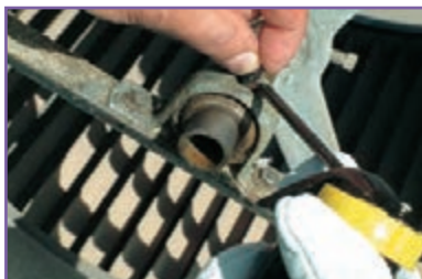
ث- روغن‌کاری یاتاقان‌ها
