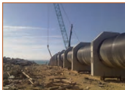
ت - احداث خطوط لوله
