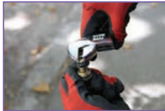
ج - جایگزینی واشر آب‌بندی و سفت کردن آن
